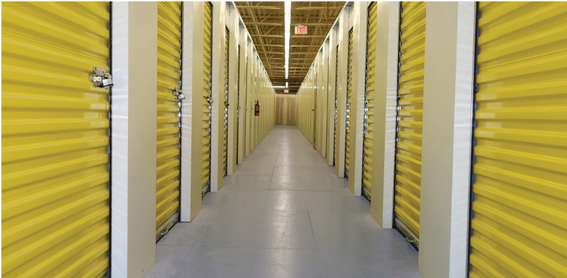
Después de tres años de actividad, los paneles ResinDek® en la 2ª planta todavía se ven muy bien en All Canadian Self-Storage.
